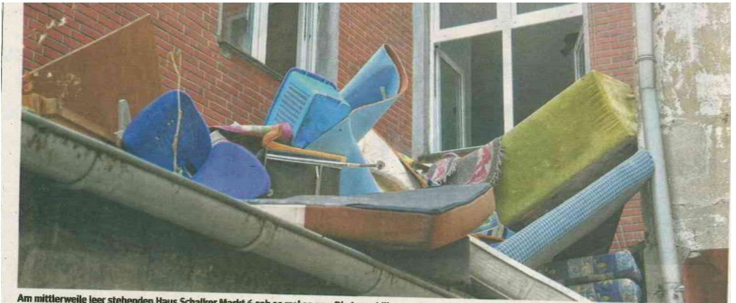
Am mittlerweile leer stehenden Haus Schalker Markt 6 sah es mal so aus. Die Immobilie war die erste, die die Stadt für unbewohnbar erklärt hatte. FOTO: JO KLEINE-BÜNING
